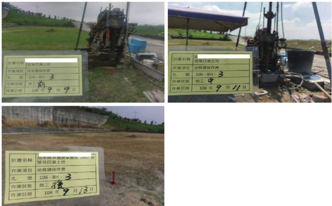
圖 4-1-6 基地現場施工照片(範例)
