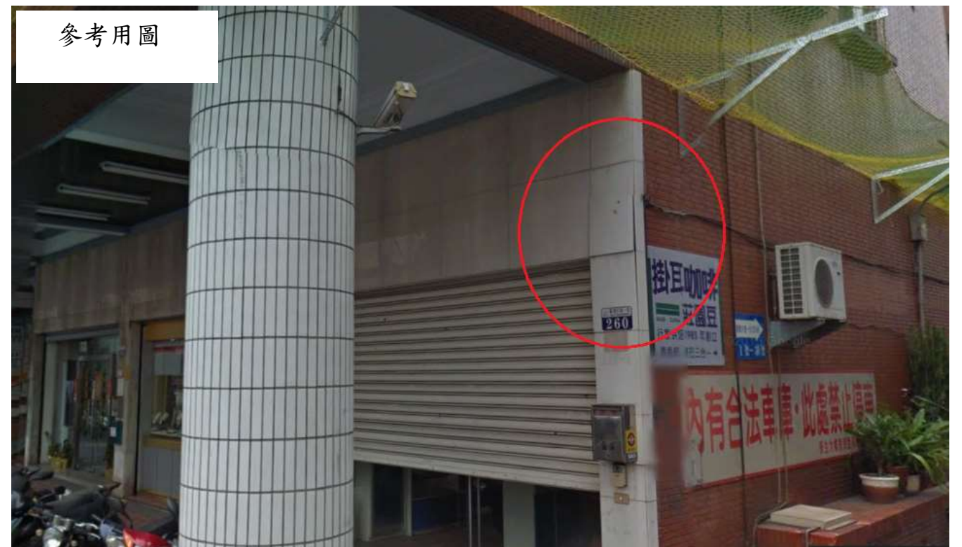
一樓大塊磁磚已損壞多處須更新
