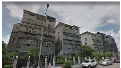
D. 南側「住一之一」街廓現況
