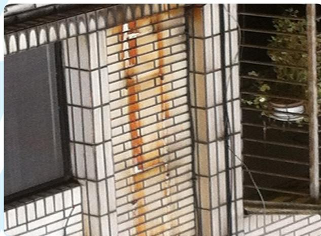
▲外牆表面污損情形
