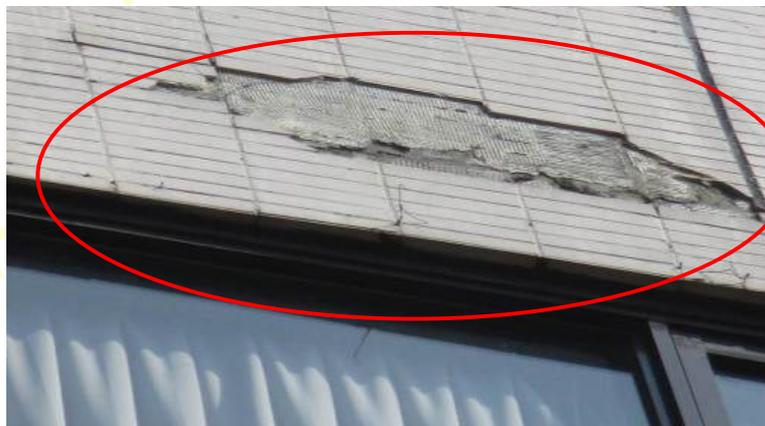
▲建築物外牆有大片磁磚剝落
