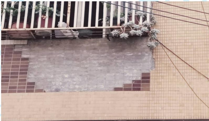
▲建築物外牆磁磚出現剝落情形
