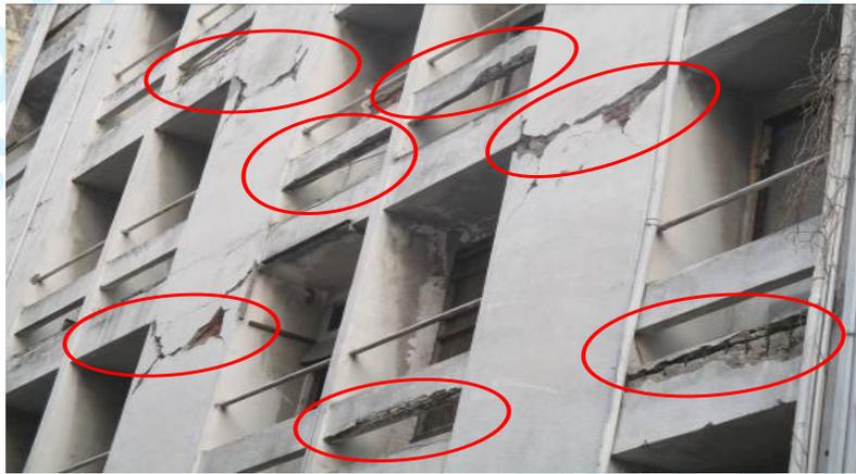
▲建築物外牆磁磚出現裂縫及剝落情形
