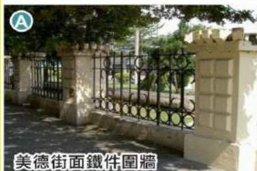
美德街面鐵件圍牆
