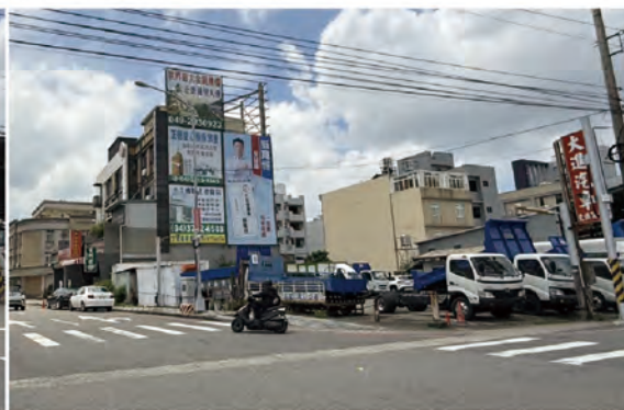
② 基地東北隅現況
