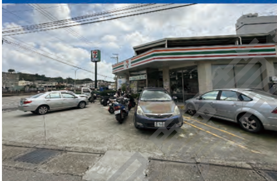
① 基地西北隅現況
