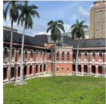
臺中州廳修復後風貌(攝於 112.9)
