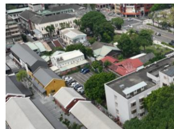
民生路附近舊有建物
