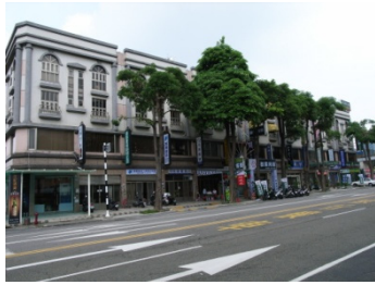
沿街店舖式住宅
