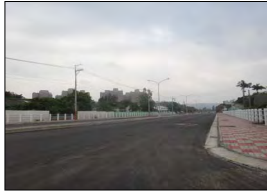
圖 3-3 鎮政路計畫道路現況
