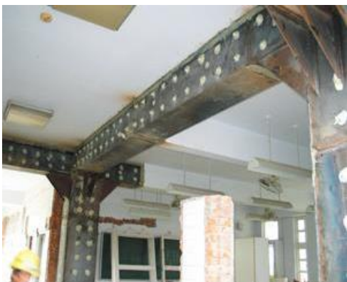
建物結構補強
